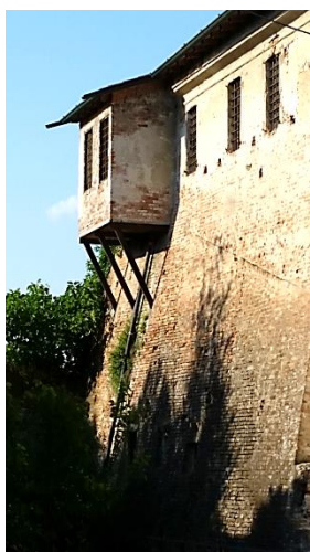
La cinta muraria
